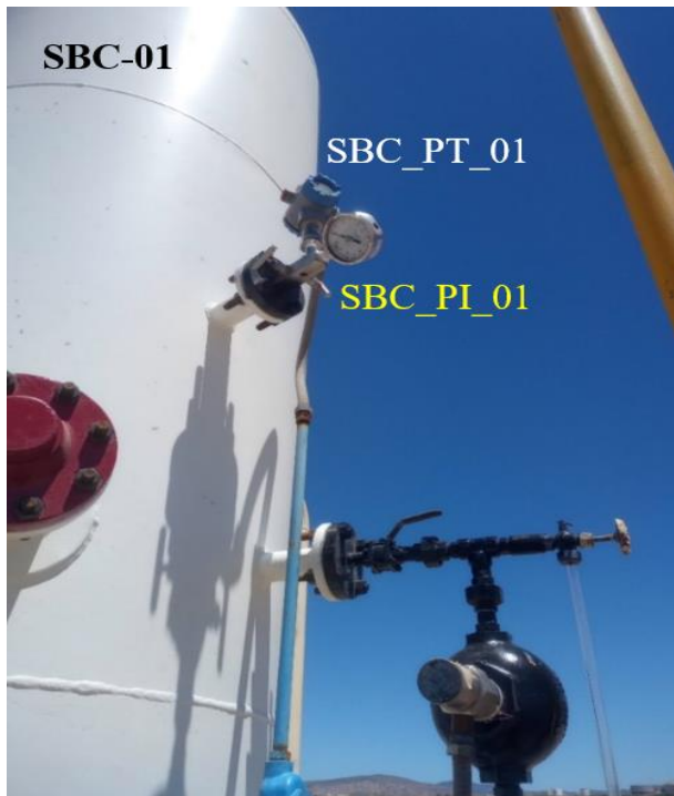
Figura 2.2 Indicador local y remoto de presión del separador de control
