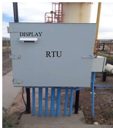
Figura 2.6 Exterior RTU a rediseñar.
