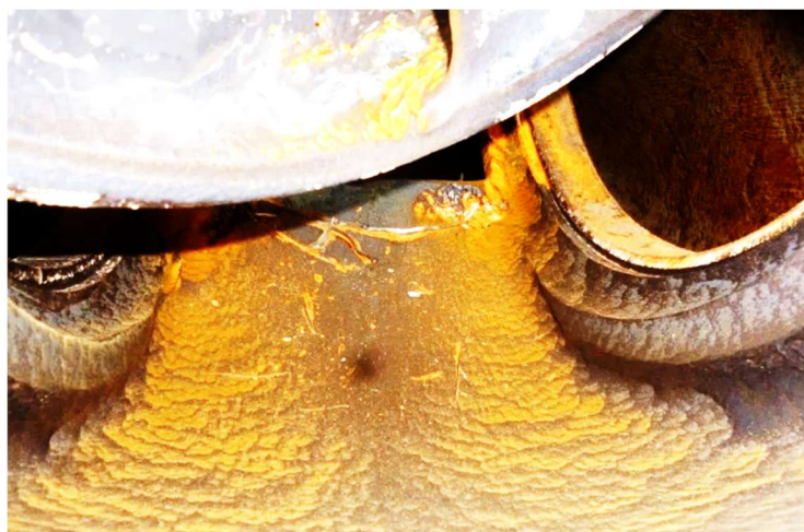
Imagen 37 - Daño por Presencia de Partículas Abrasivas en la Voluta
