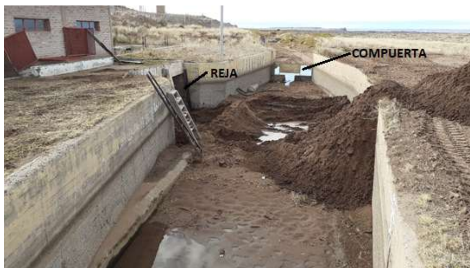
Imagen 13 - Obra de Toma Central de Bombeo “La Picacita” Junio 2019
