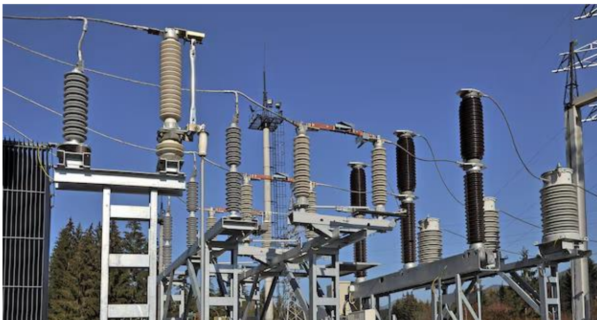
Figura 17: Elementos de maniobra de una ET.
