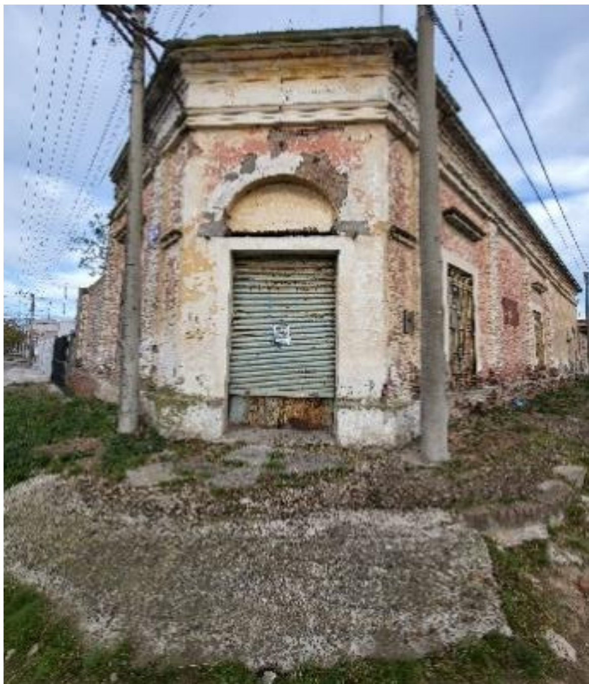
Imagen 27. Ochava de Suipacha esquina Alte. Brown Sur.
