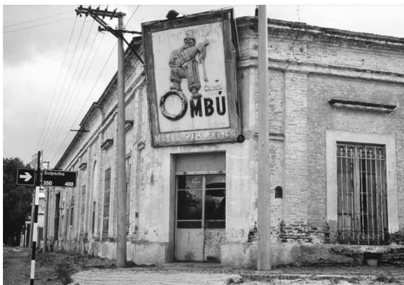
Imagen 19. Fachada de Suipacha y Alte. Brown Sur en 2006.
