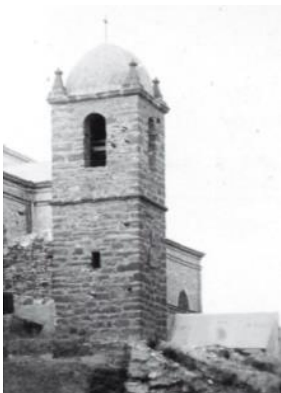
Imagen 4. Torre del Fuerte Nuestra Señora del Carmen antes de la restauración.
