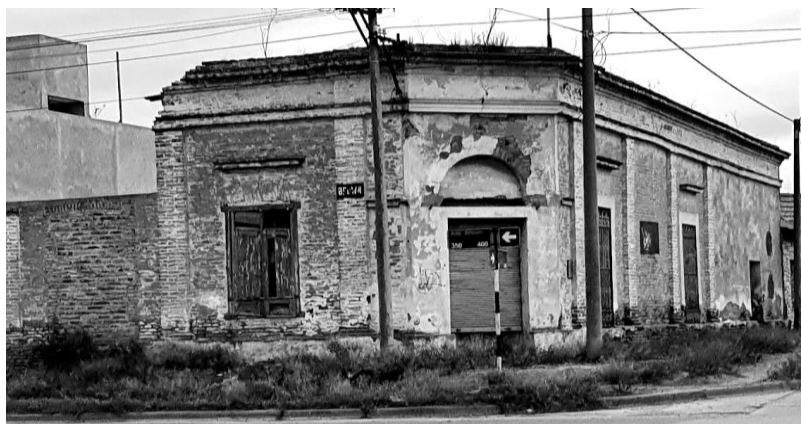
Imagen 20. Fachada de Suipacha y Alte. Brown Sur en 2021.
