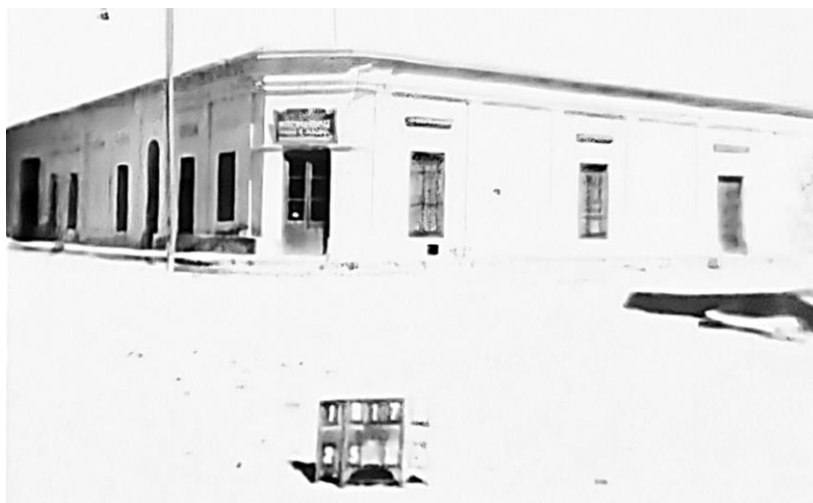
Imagen 18. Fachada de Suipacha y Alte. Brown Sur en 1941.
