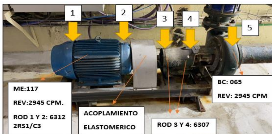
Figura 68 : Descripción de los componentes del equipo (Desarrollo propio)
