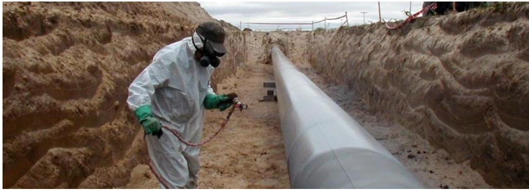
Fig. 5 – Aplicación de revestimiento protector de corrosión a una tubería que será luego enterrada [9].
