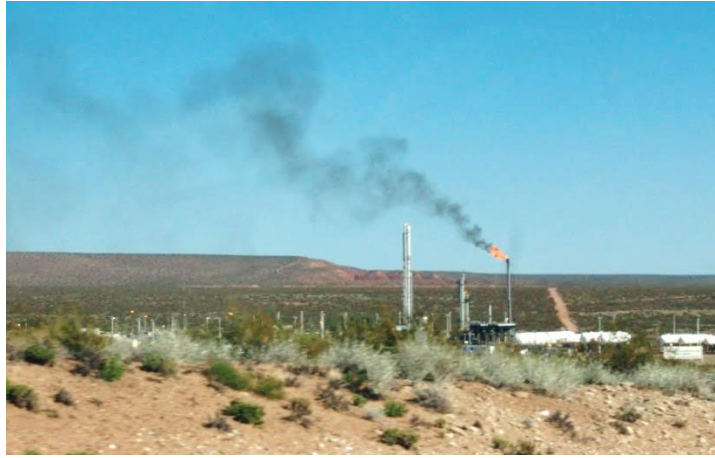
Figura 5.1: Pluma de Venteo de Planta de Recuperación de Condensables en Cuenca Neuquina
