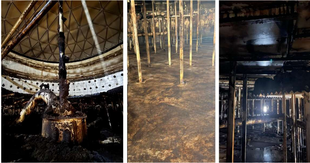
Foto 5: interior del Tanque. Imagen central y de la derecha luego de la limpieza.
