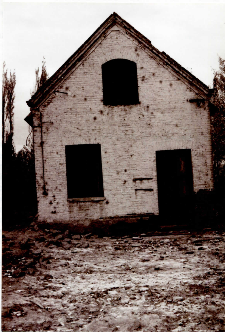
Frente de la botellería, en el comienzo de la Bodega funcionaba a la vez como laboratorio.
