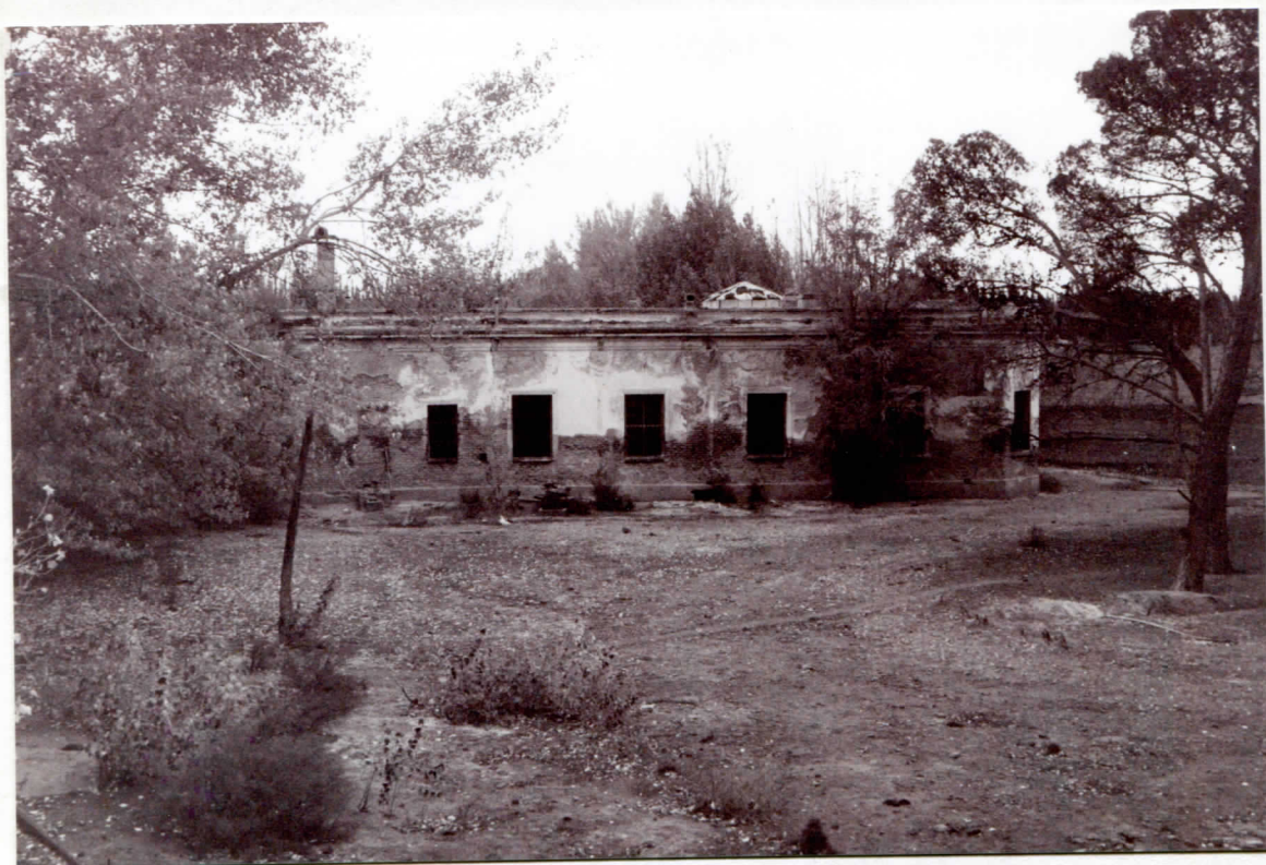
Vista lateral del Chalet, 1996.
