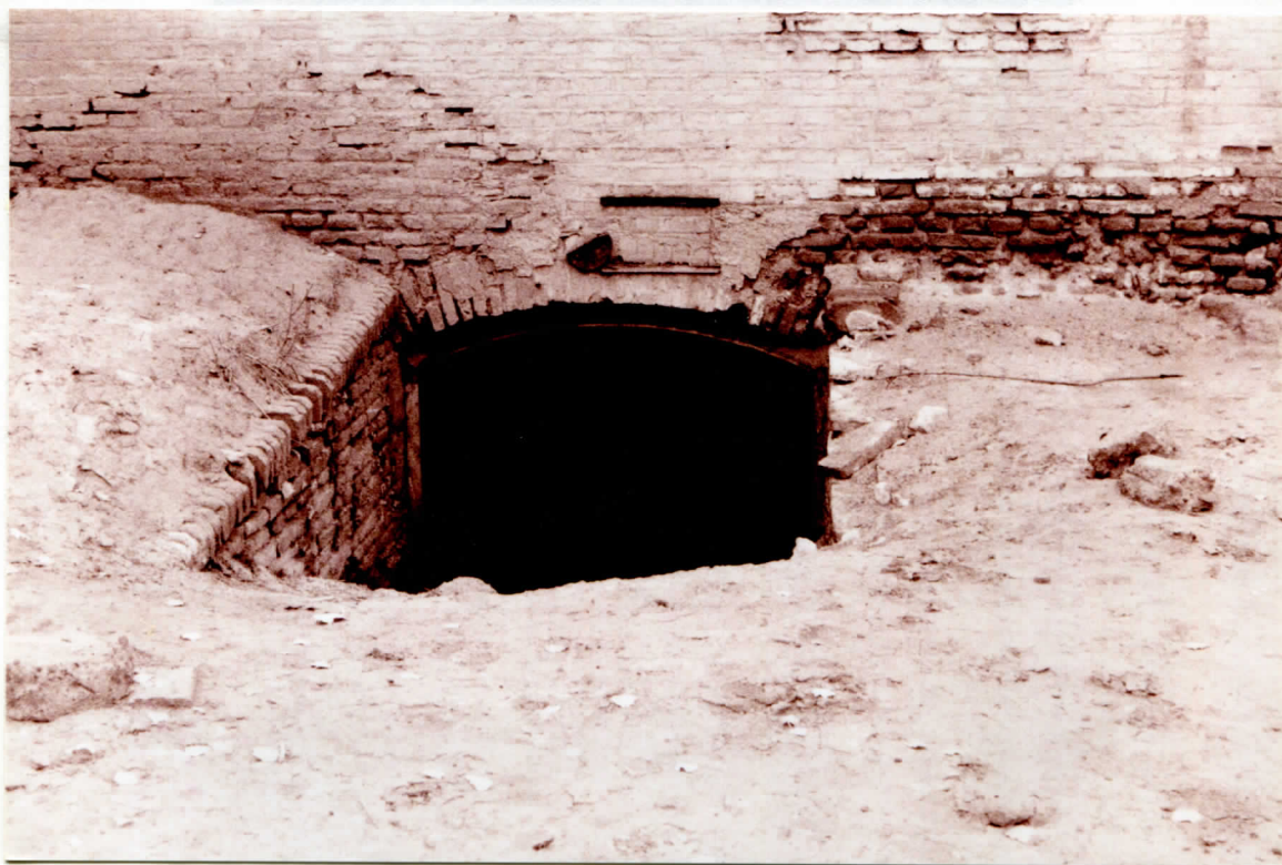
Sótano de la botellería
