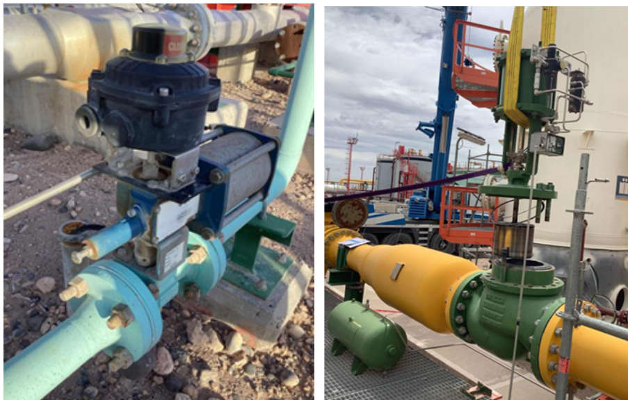
Figura 20. Intervención en paro de planta a válvulas.
