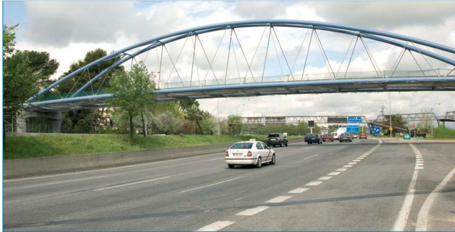
Figura 2.17. Estructura metálica en arco atirantada tipo Nielsen sobre la Autopista de La Coruña (A-6). Tomado de Anillo Verde Ciclistas. Finalización de la Tercera y Última Fase , Ayuntamiento de Madrid, 2007, ( https://www.madrid.es )
