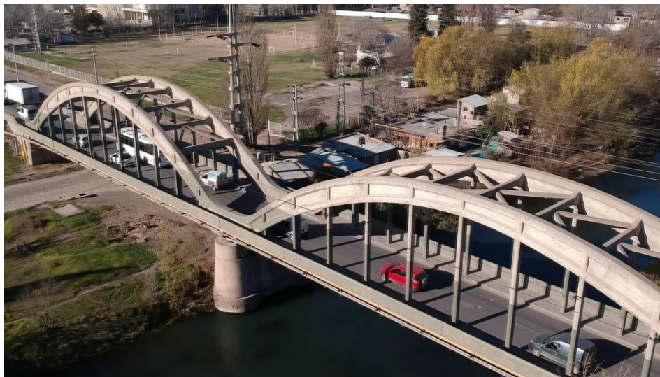
Figura 2.16. Puente Carretero entre Neuquén y Cipolletti. Se observa un marcado aumento de la sección en ciertos sectores del arco. Tomado de Neuquén al instante, 2024, ( https://www.neuquenalinstante.com.ar )
