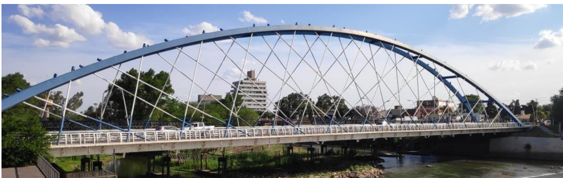
Figura 2.20. Puente en arco metálico tipo Network en la Localidad de Villa María, Provincia de Córdoba. Tomado de Turismo Córdoba, ( https://villamariaargturogs.jimdo.com/turismo/ )
