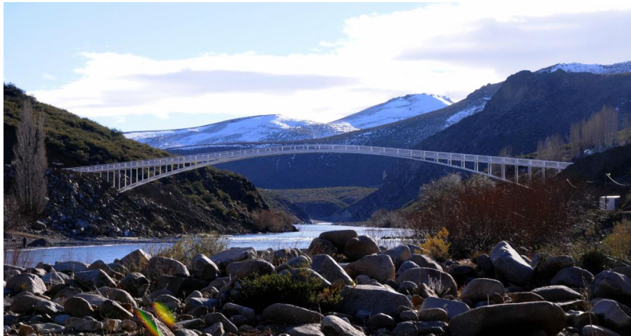
Figura 2.7. Puente Butalón Norte sobre el río Neuquén. Tomado de Neuquén Informa (Gobierno de la Provincia de Neuquén, 2015 ( https://www.neuqueninforma.gob.ar )).
