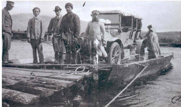
Balsa en el Río Collón Curá
