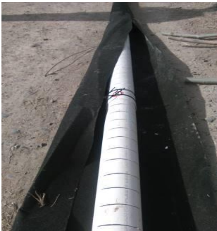
Figura 3: Construcción del dren.
