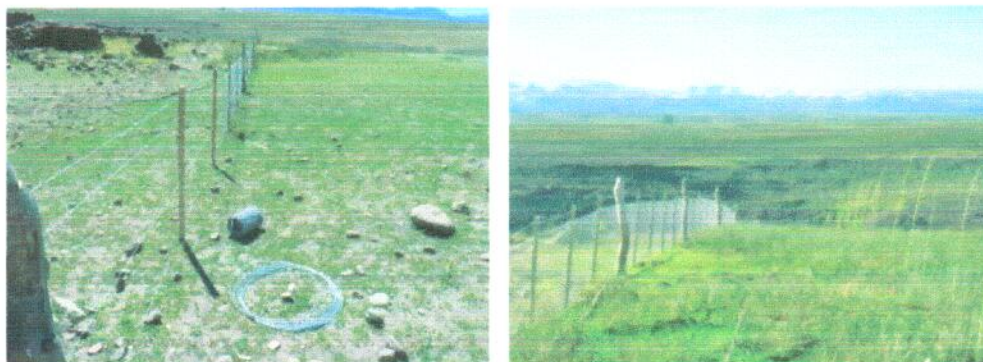
Imagen N° 48 A y B: construcción y finalización del cierre perimetral
