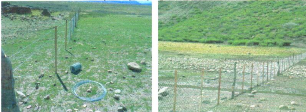
Imagen N°3 A y B: cierre perimetral con alambre tejido
