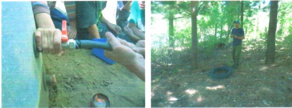
Imagen N° 60 A y B: instalación sistema de riego
