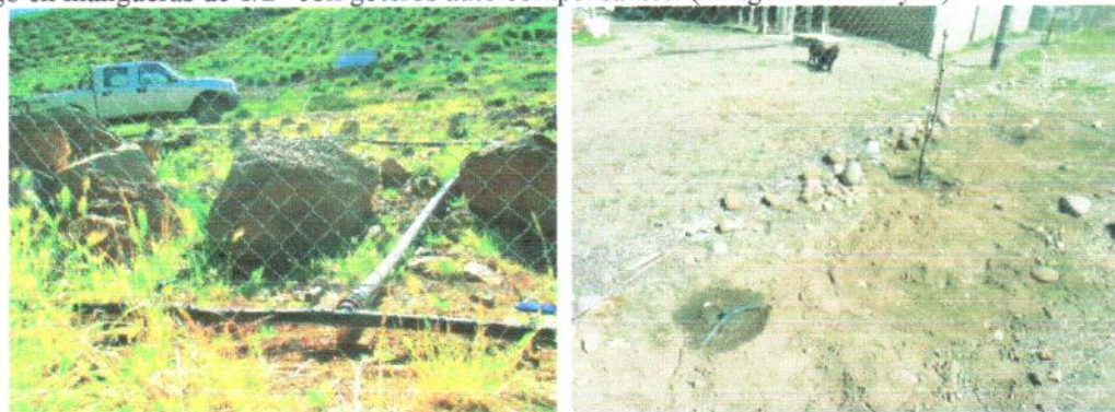
Imagen N°13 A y B: instalación de sistema de goteo.
