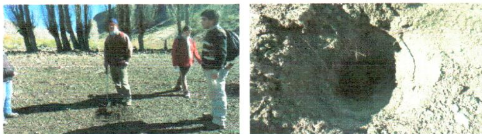
Imagen N°45: realización de calicata.
