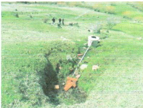
Imagen N°42 A y B: captación de vertiente y tanque de acumulación
