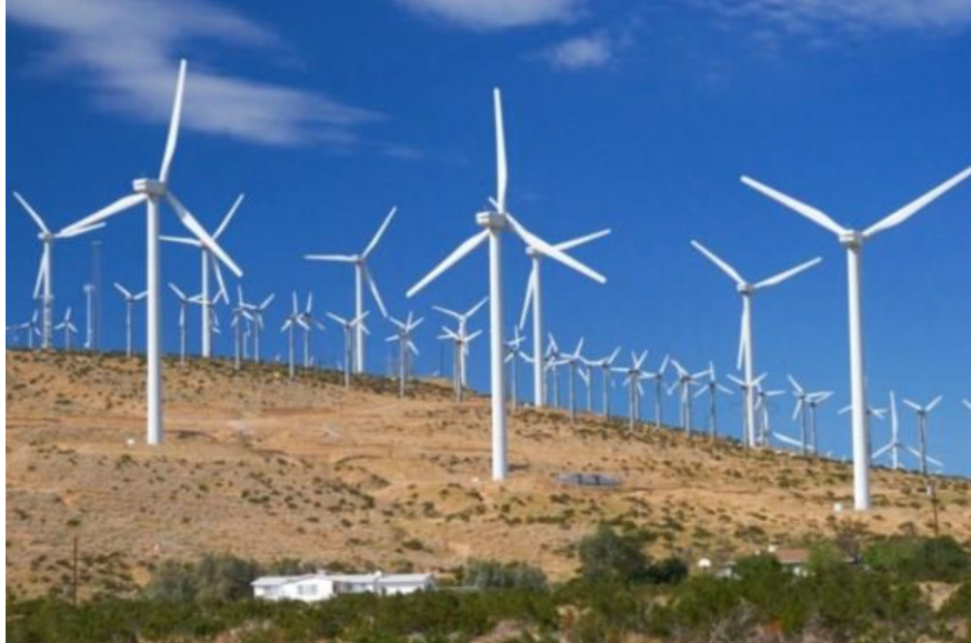
Figura 14.13: aerogeneradores de eje horizontal de gran generación (Audisio, Álvarez et al.; 2018).
