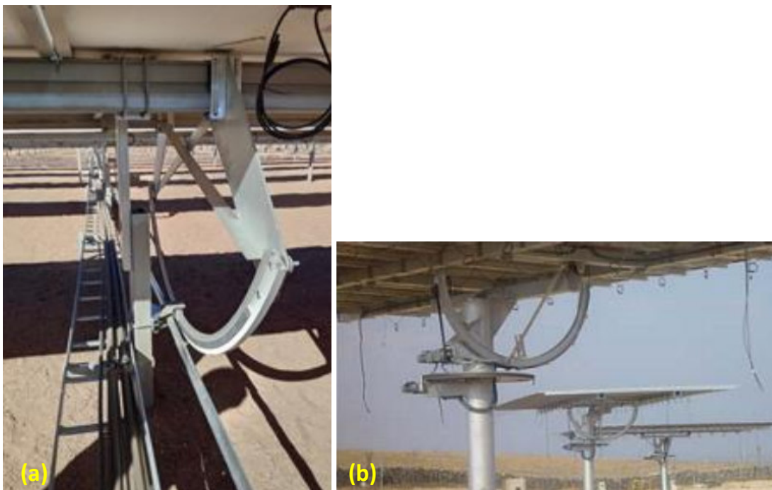
Figura 14.46: (a) Seguidor de un eje; (b) Seguidor de dos ejes (Fuente: IMEDEXA; Morrone SFV; 2019).
