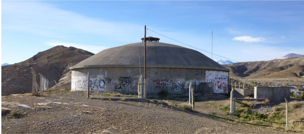
Figura N° 24: TANQUE DE RESERVA DE 3000 M 3
