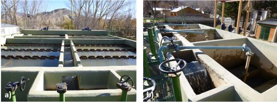
Figura Nº 21: a) DECANTADORES b) FILTROS RÁPIDOS DE LA PLANTA POTABILIZADORA DE CHOS MALAL
