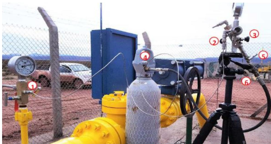
Figura 4.2: ‘Medición en la línea del gasoducto con Bureau of Mines’.
