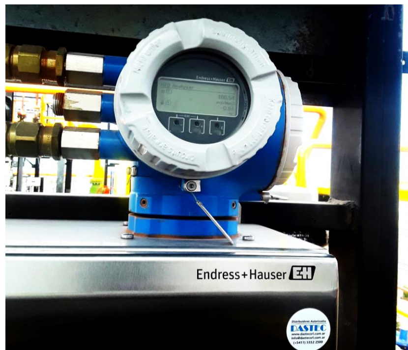
Figura 5.1: ‘Medición con el Higrómetro a la salida de la planta’.
