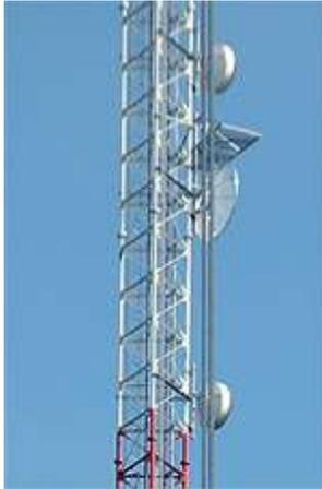
**Imagen 8: Vista tramos reticulados abulonados infraestructura de comunicación**
