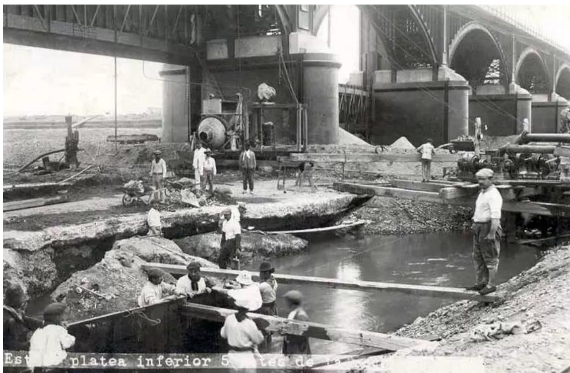
Figura 5: trabajadores en la construcción del Dique Ingeniero Ballester (etapa avanzada)
