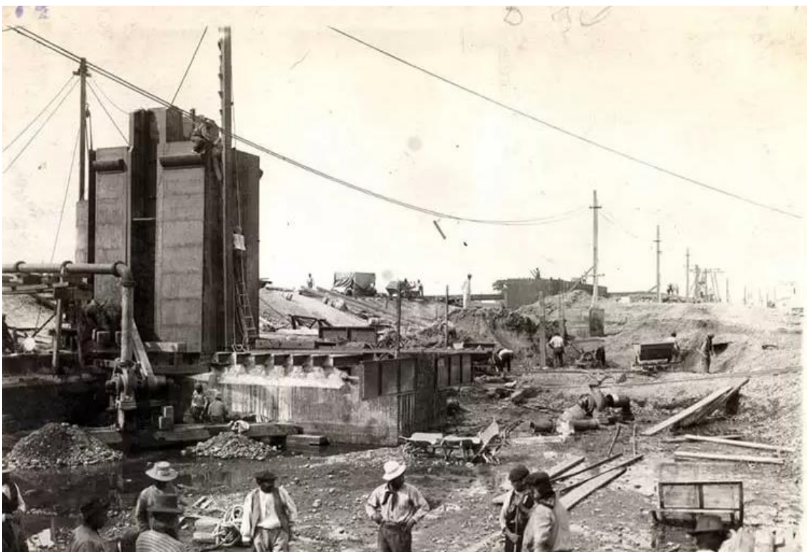
Figura 4: trabajadores en la construcción del Dique Ingeniero Ballester (etapa inicial)
