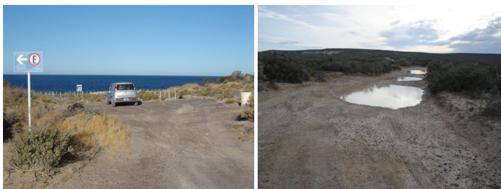
Figuras N°39 y 40: Acceso vehicular con compactación e impermeabilización del sustrato.
