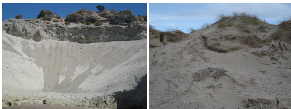
Figuras N° 26 y 27: Remoción en masa en frente acantilado y en tope de las barrancas.
