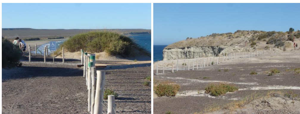
Figuras N° 37 y 38: Probable caída de visitantes ocasionales por la barranca del acantilado.
