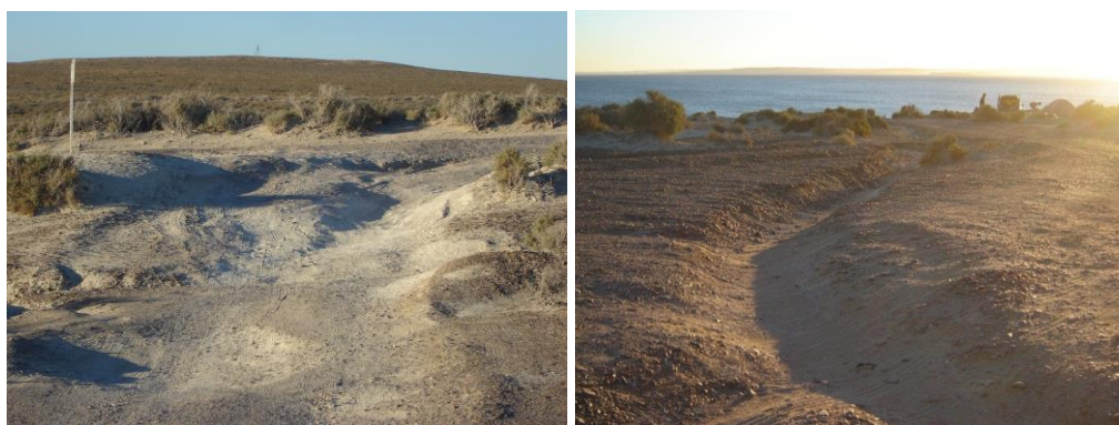
Figuras N° 56 y 57: Acceso vehicular con compactación e impermeabilización del sustrato.
