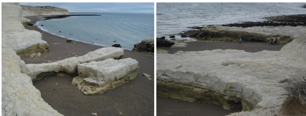
Figuras N° 42 y 43: Erosión marina en base de acantilado general y abajo de Estacionamiento-Mirador Punta Ameghino.
