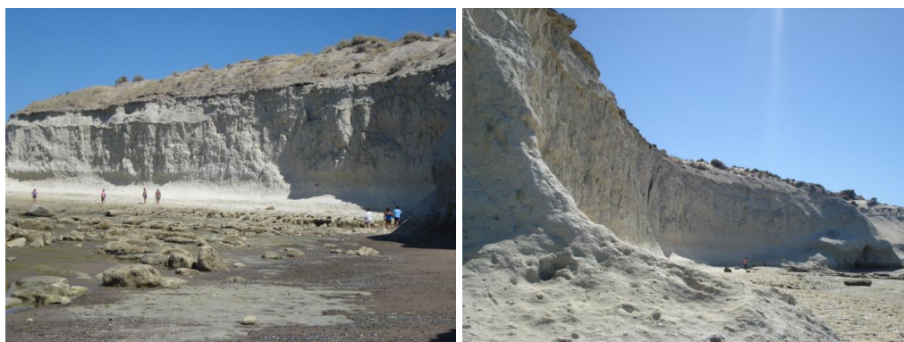
Figuras N° 24 y 25: Erosión marina en base de acantilado gral y abajo de sitio Punta Dorado.
