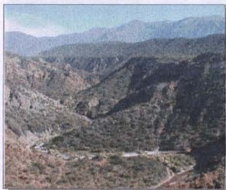
FiguraN°13:Vista panorámica del Arroyo Divisadero Largo
