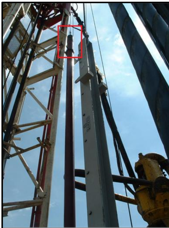
Figura 38. Lifting Sub en la parte superior de la tubería.
