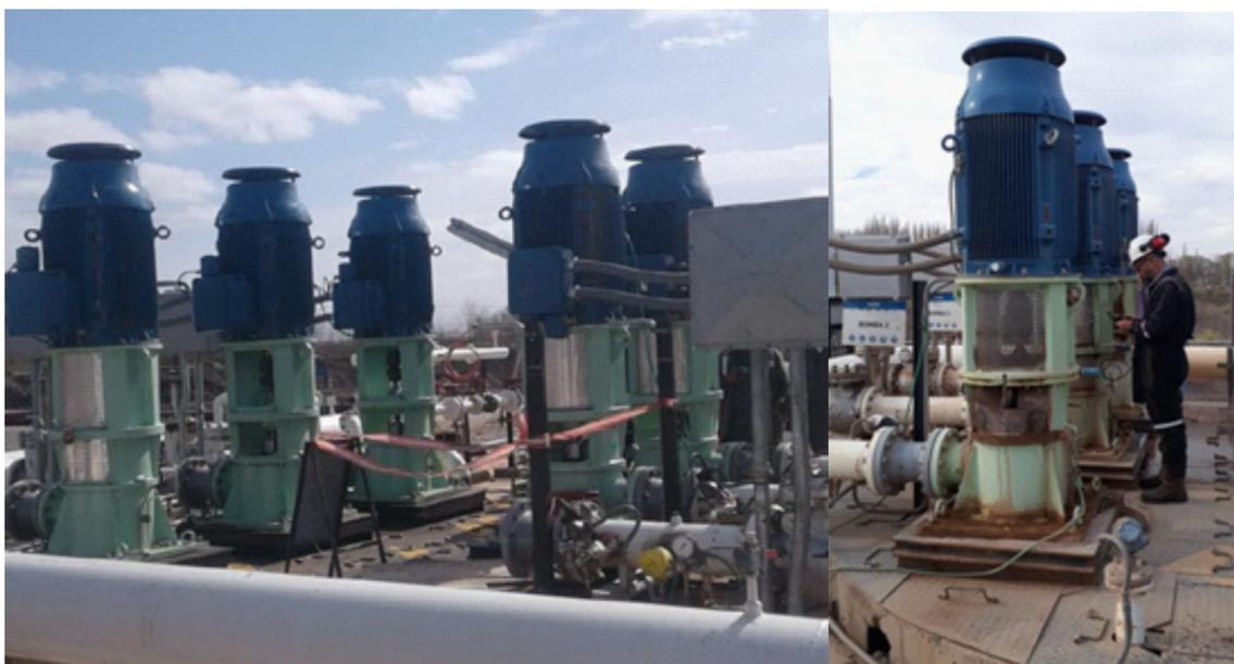
Figura 25. Detalle de las bombas centrífugas verticales del sistema de captación.
