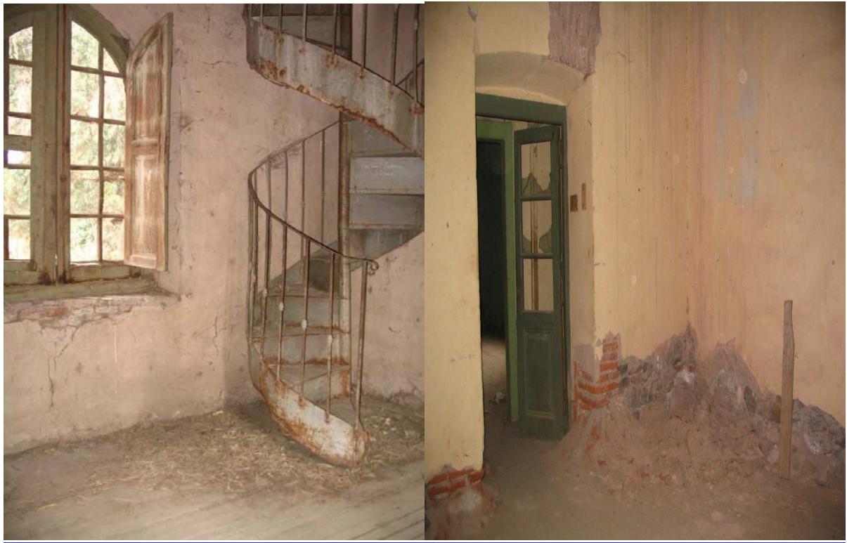
Foto E24: "Torre Talero" Interior estado actual años 2008.
