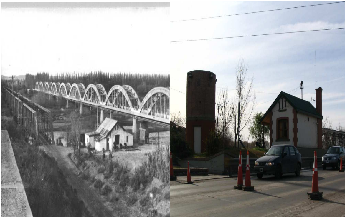
Foto E10 : “ vista Casa del guardapunte, con el puente de Ferrocarril y puente carretero de fondo”
