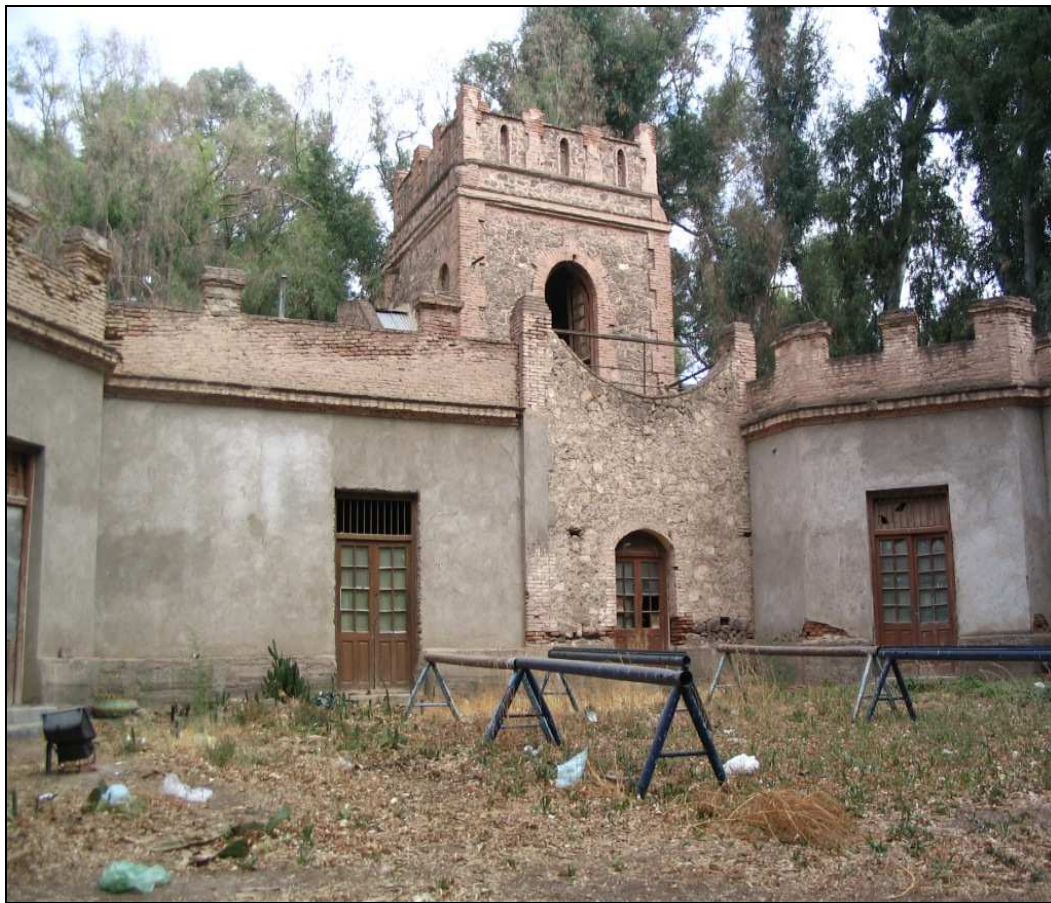
Foto E24: “Torre Talero”
