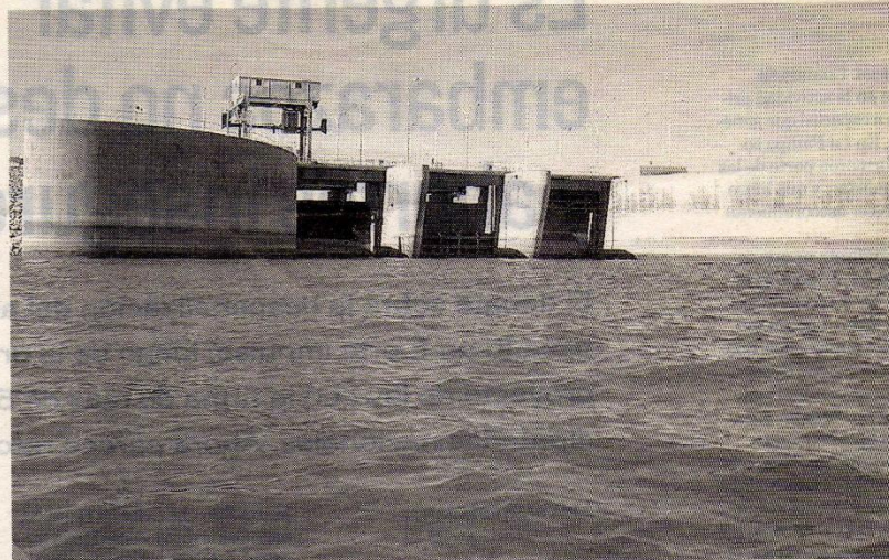
El bajo nivel del lago impide funcionar a las dos turbinas de la central hidroeléctrica de Casa de Piedra.
