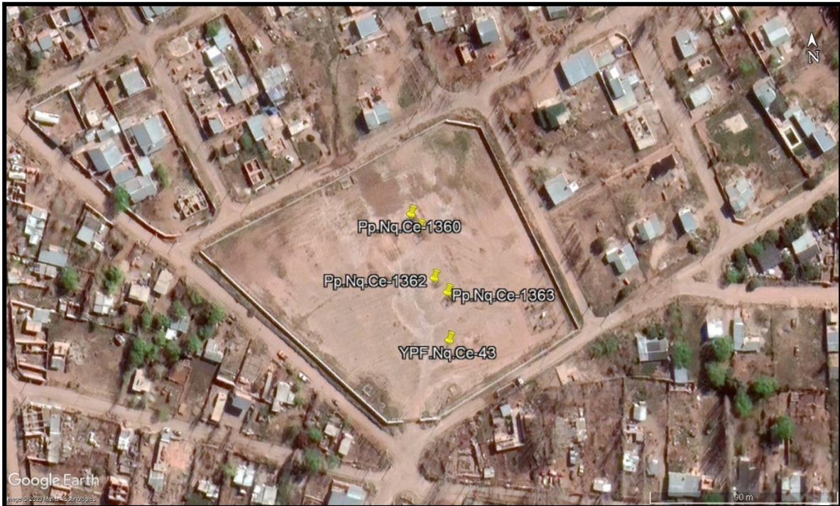
Figura 33: Vista cenital de locación/isla con presencia de multipozos. Se observa como la locación esta implantada sobre un drenaje impidiendo la circulación del agua, pudiendo generarse ante un evento torrencial inundaciones en el sector urbanizado.
