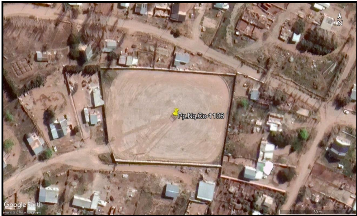
Figura 35: Vista cenital de locación/isla con único pozo.
