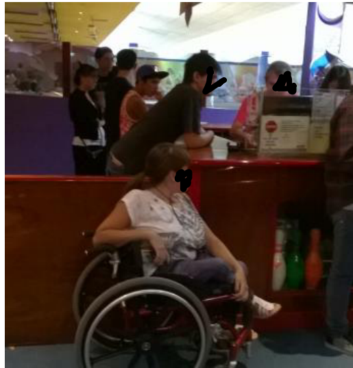
Mostrador excesivamente alto
