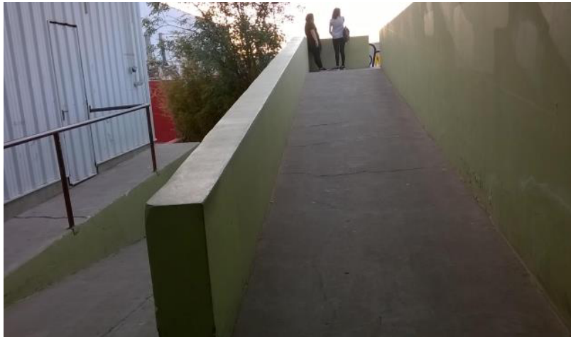
Rampa demasiado inclinada
