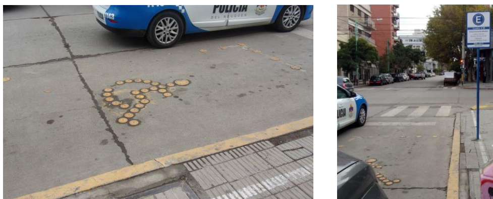
Estacionamiento sin señalización vertical
