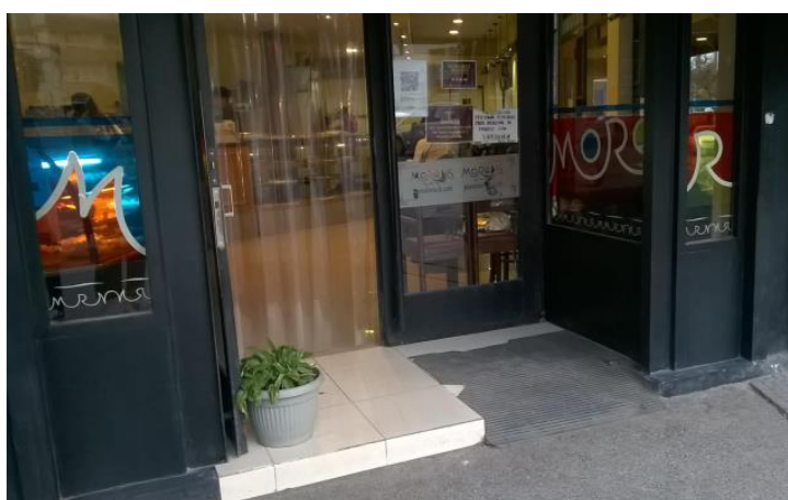
Puerta con rampa bloqueada
