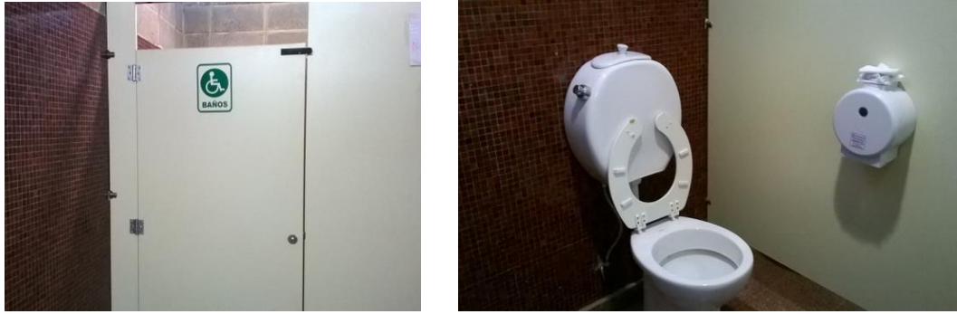
Foto 72. Sanitario público Parque Central Este Fuente: M. B. Arce. 21/04/2016
