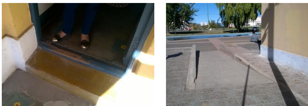
Foto 64. Entrada y rampa Museo Paraje Confluencia Fuente: M. B. Arce. 21/04/2016
