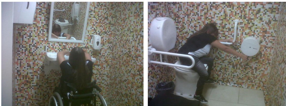
Sanitario adaptado con medidas inadecuadas
