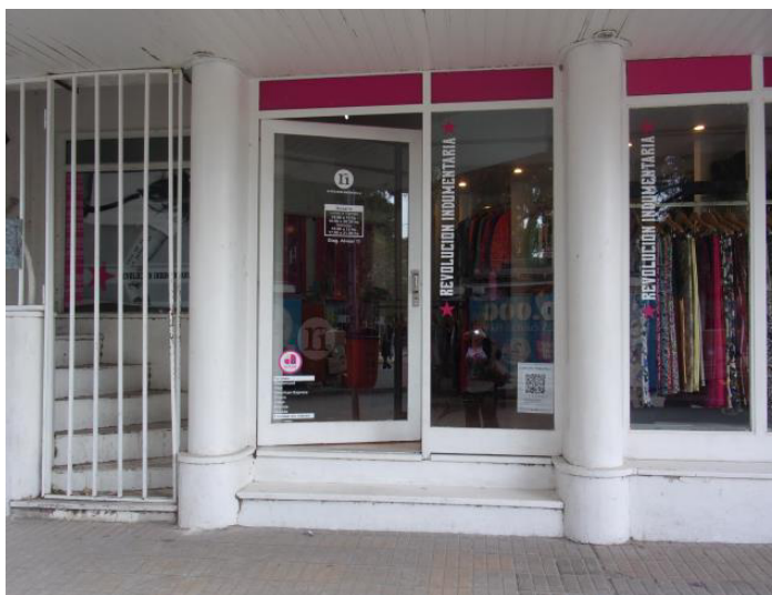
Escalón en acceso a local de ropa
