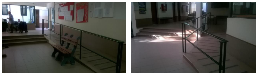
Foto 20. Rampa Interior Escuela Superior de Música
