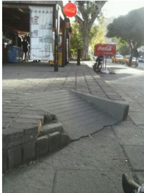
Rampa demasiado inclinada
