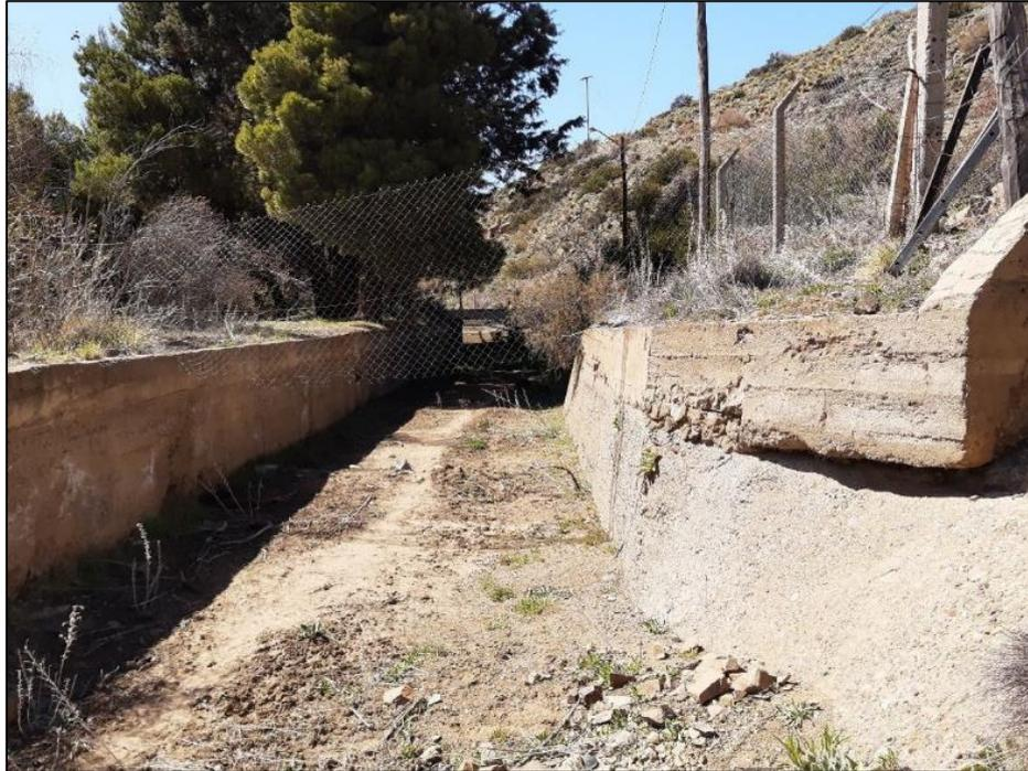
*Figura 5.17 - Acceso del canal a cámara de carga*
