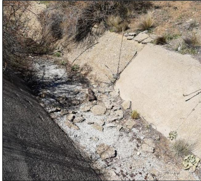
*Figura 8.14 - Hormigón del canal en mal estado*
