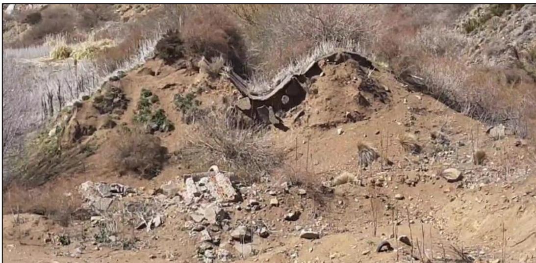
*Figura 5.15 – Vista sección del canal destruido por el alud del año 2002*
