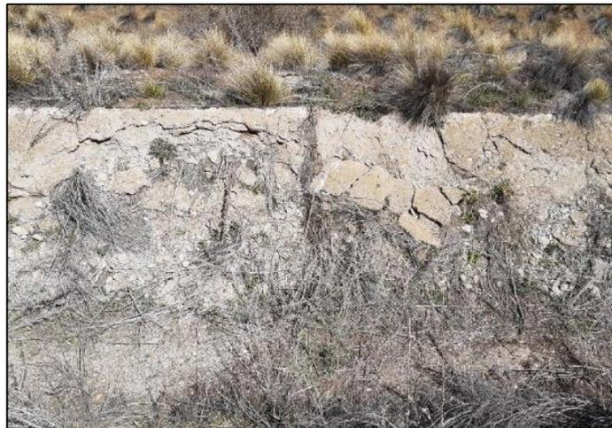
*Figura 8.15 - Hormigón del canal en mal estado*
