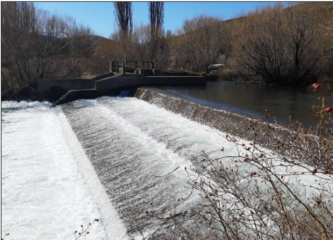
*Figura 5.3 – Azud de derivación desde margen izquierda*
