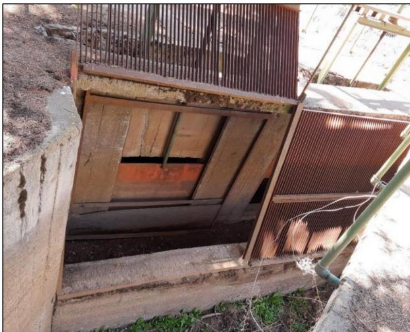
*Figura 5.21 - Rejillas de toma previas a tubería de presión*
