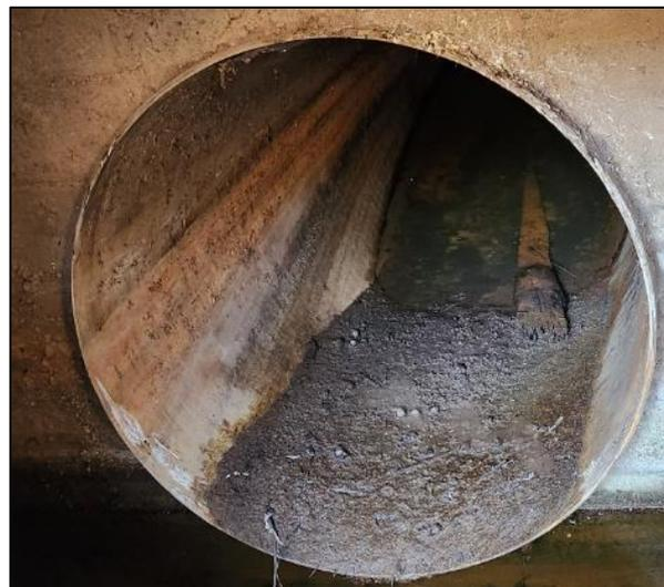
*Figura 8.21 - Inicio tubería de presión de acero*
