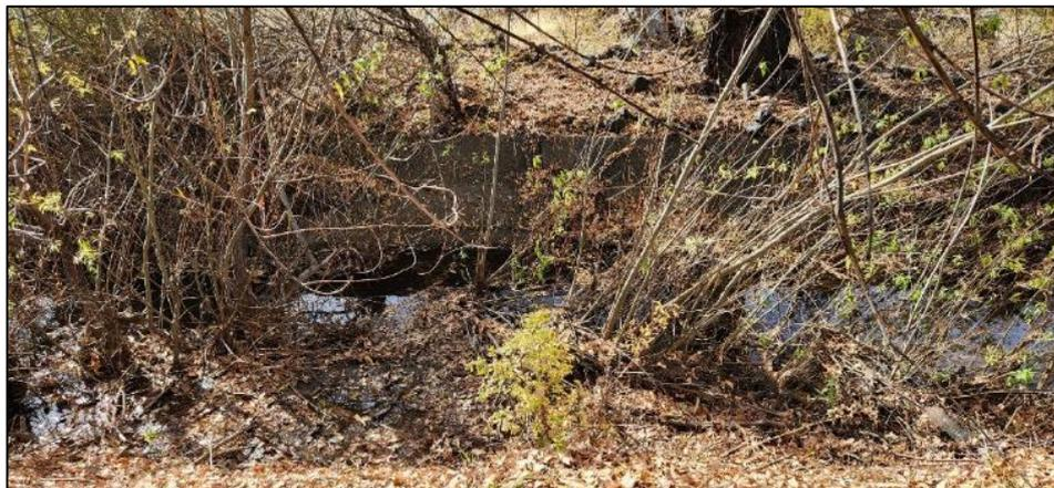
*Figura 8.10 - Presencia de vegetación sobre el canal*
