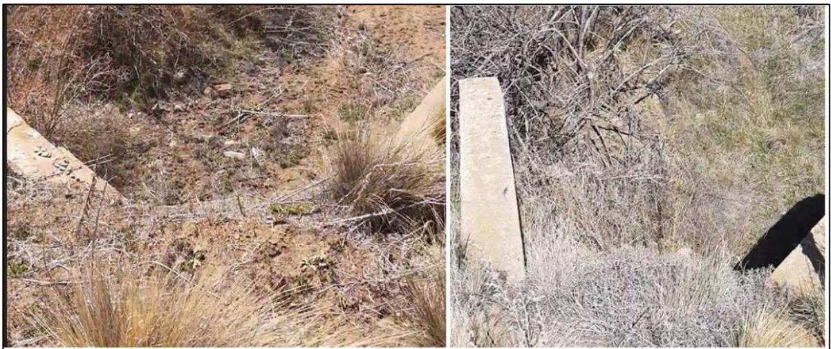
*Figura 5.13 – Alcantarilla de desagüe – Tipo cajón con alas de hormigón armado*
