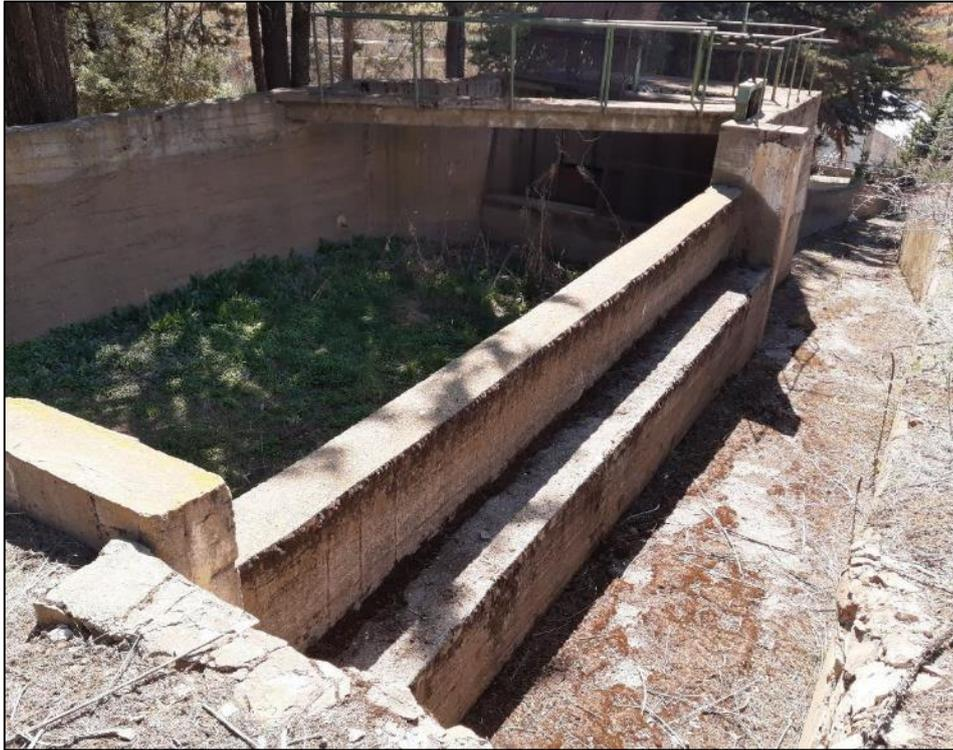
*Figura 5.20 - Aliviadero de cámara de carga y canal de descarga*
