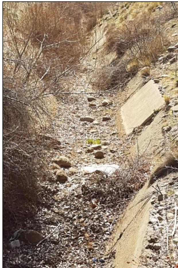
*Figura 8.13 - Placas de hormigón con asentamientos apreciables y presencia de rocas*
