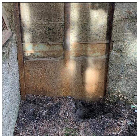
*Figura 8.22 - Compuerta de descarga de cámara de carga*
