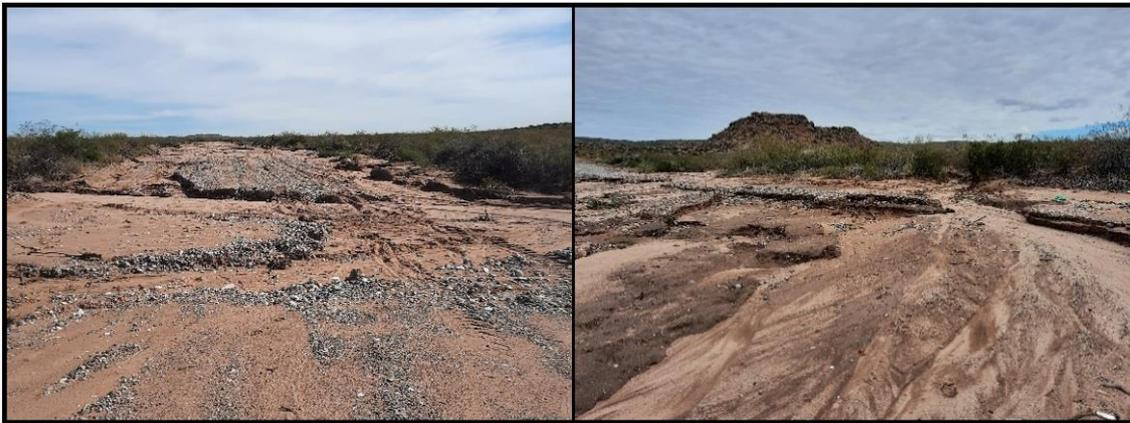
Figura 9: Se observa el daño provocado en los caminos que cruzan cauces efímeros por la lluvia del 19 de abril del 2021.
