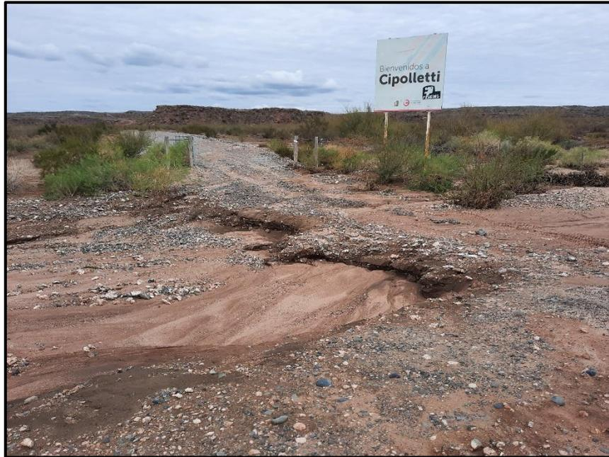
*Figura 51: Acceso al barrio por la RP N°76 afectado por los caudales generados por la cuenca I en la tormenta del 19 de abril.*
