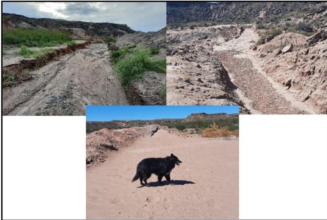
Figura 14: “Canales de guarda” rellenos con sedimentos arenosos y limo-arcillosos luego de la tormenta producida el 16 de diciembre del año 2021.
