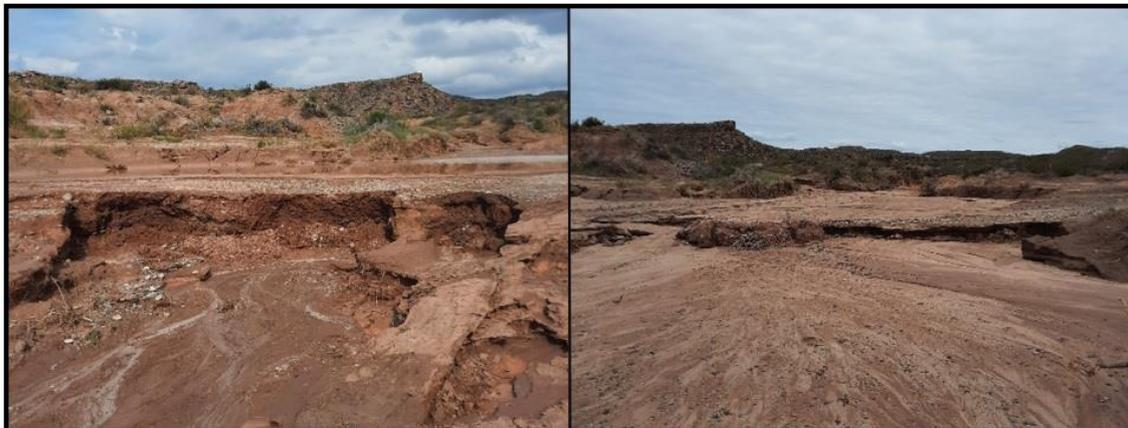
*Figura 13: A la izquierda se observa el camino que intersecta un cauce efímero, fuertemente disectado por los caudales generados en la tormenta del 19 de abril del 2021 y posteriormente (a la derecha), rellenado por sedimentos arenosos por la lluvia del 20/21 de abril.*
