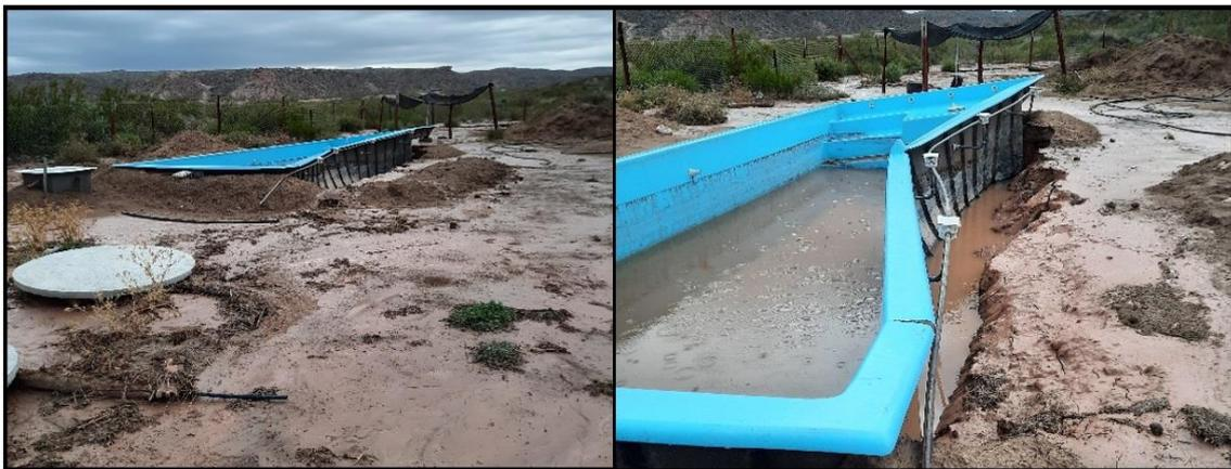
*Figura 11: Piscina de fibra de vidrio destruida por los caudales generados a efectos de la tormenta.*
