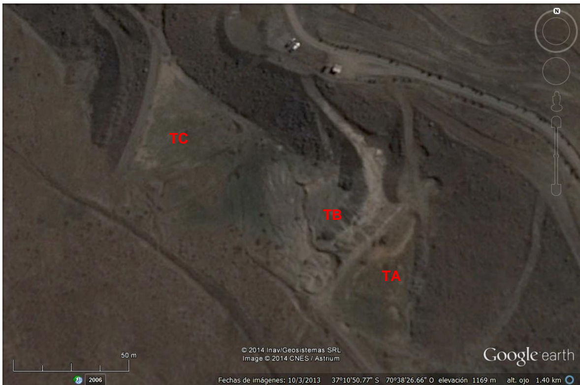
Figura 9. Ubicación y disposición de los taludes (TA, TB y TC) en el PAM
