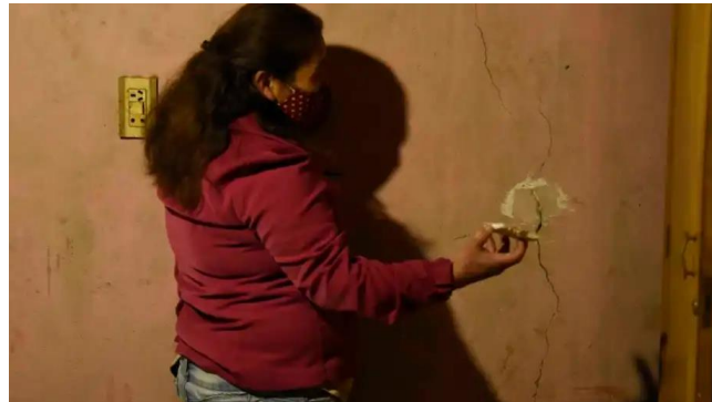
Imagen 10: Vecina de la localidad de Sauzal Bonito muestra los daños en las paredes de su vivienda producto de la actividad sísmica. (Diario LM Neuquén)
