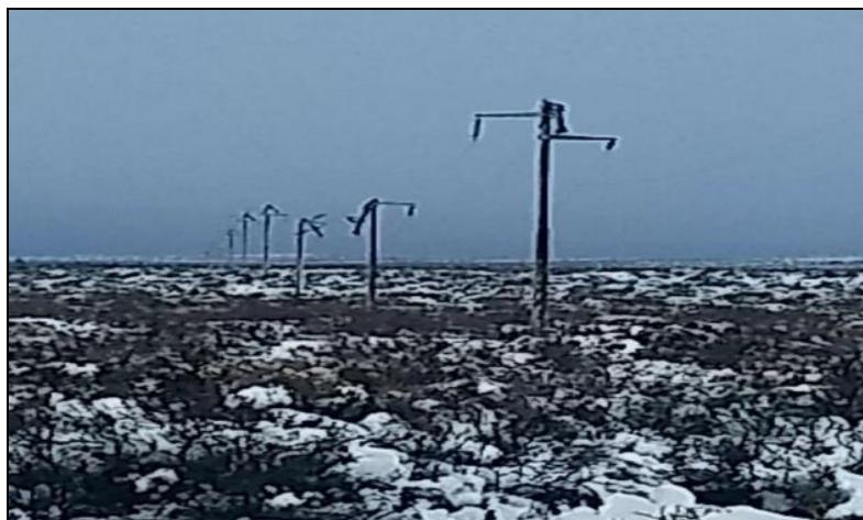
Fig. 4 - Reparación de la línea con estructuras provisionarias
