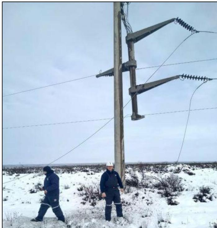
*Fig. 3 - Estructuras colapsadas de la línea LAT-132 KV*
