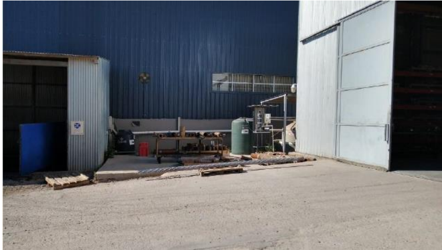
Figura 2-3: Zona de tanques.
