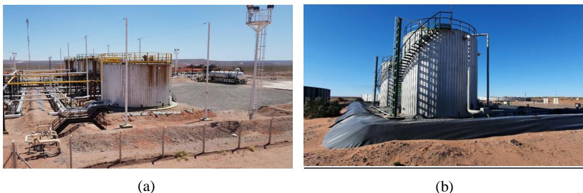
Figura 2.8: (a) Planta de Tratamiento Primario. Tanque con base elevada, (b) Dique Perimetral a la zona de tanques.
