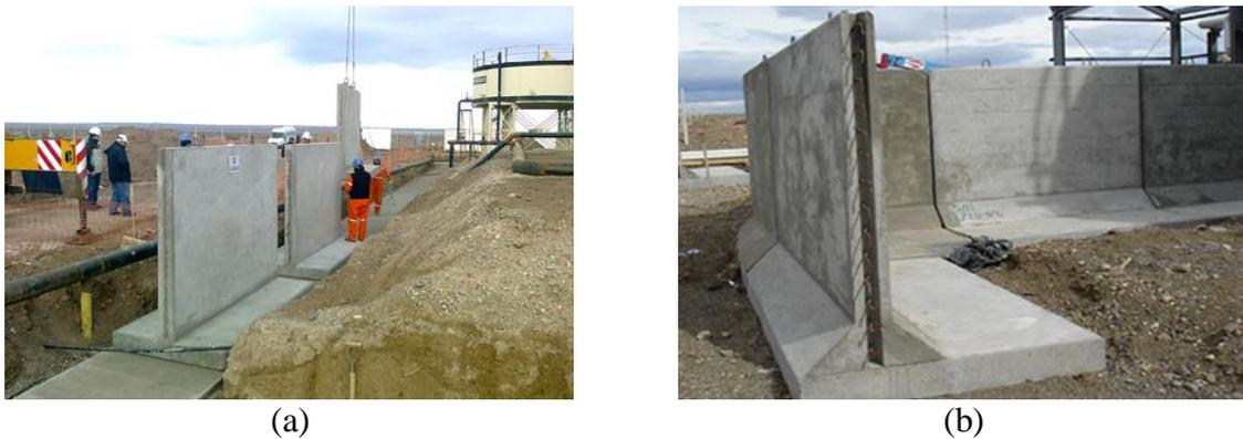
Figura 2.12: Tabique premoldeado de hormigón, (a) Izado de los tabiques en obra, (b) Encastre vertical
