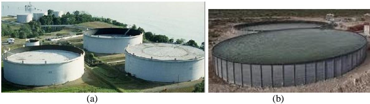
Figura 2.4: Tanque: (a) de Techo Plano Flotante, (b) Sin techo.
