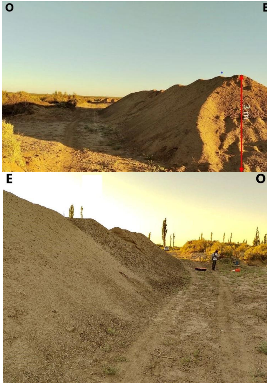
Figura 33: Biopilas. Indicadas en la imagen 32 como 33a y 33b respectivamente.
