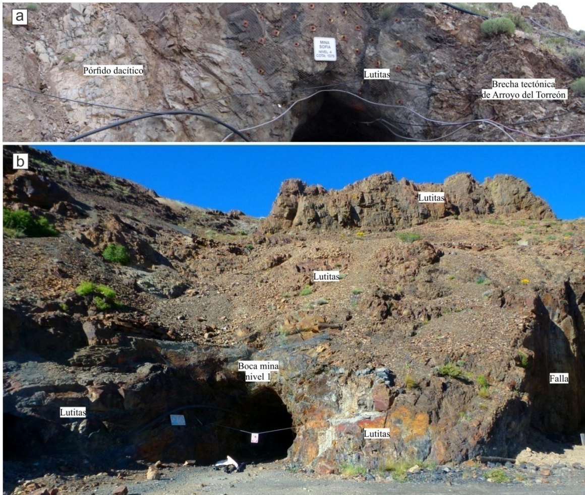
Figura 2.22. a, b) Fotografías de ingreso en boca mina Sofía nivel 4 y 1 respectivamente.
