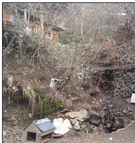
Imagen 58: fotografía del año 2018, zona con evidencias de movimientos lentos de materiales. En la parte central se observa un árbol con el tronco arqueado. En la parte inferior de la foto se observa una canalización tubular de origen antrópico que podría favorecer el riesgo por hundimiento.
