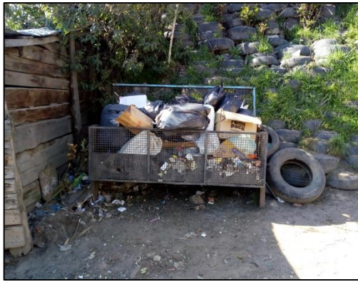
Imagen 40: Punto 6 (P6) - Cesto metálico de residuos con restos desbordado.
