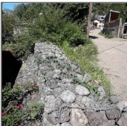
Imagen 59: Muros de contención en gaviones metálicos.
