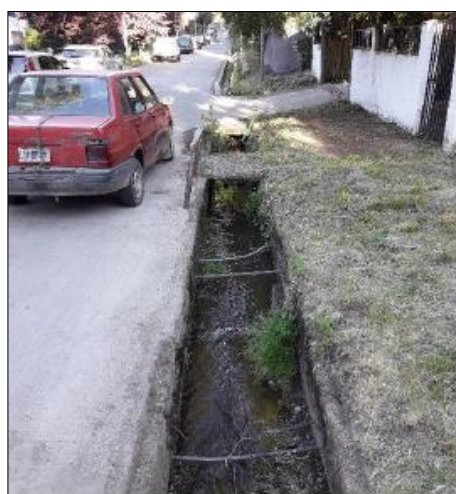
Imagen 16: Cordón de descarga del Arroyo en calle Virgen de la Nieves
