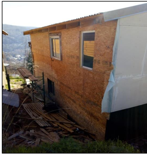
Imagen 25: Vivienda con pared de planchuelas de madera – construcción en seco-.
