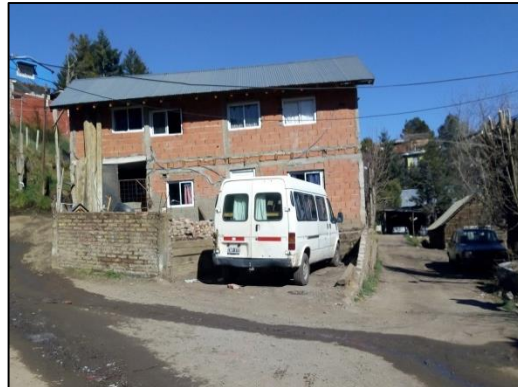
Imagen 27: Vivienda de construcción de hormigón, techo de chapa – Construcción en húmedo-.
