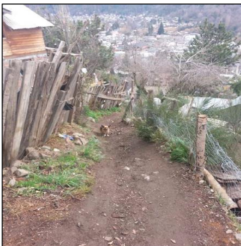
Imagen 57: Deformación en el cerco debido a procesos de movimiento lento de materiales (Reptación). Fuente: UFLO & IPVU, 2018.
