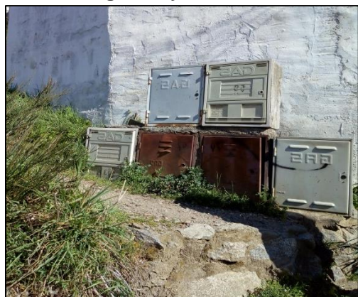
Imagen 34 y 35: Nichos de gas y pilares de electricidad amontonados.
