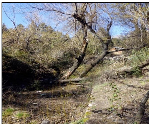
Imagen 14: Vista panorámica aguas arriba alcantarilla del arroyo y relleno de suelo.
