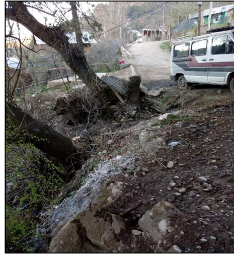
Imagen 62: Evidencia de inclinaciones de árboles.
