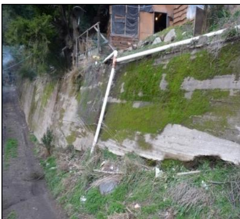
Imagen 32 y 33 Conexiones a red cloacal expuestas a la intemperie.
