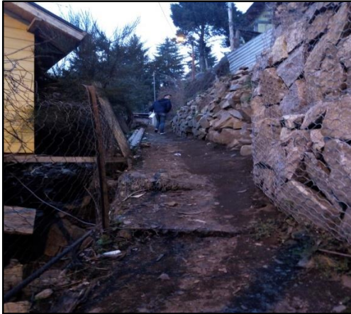
Imagen 44: Vecino circulando en sendero peatonal con muro de gaviones en lateral derecho.
