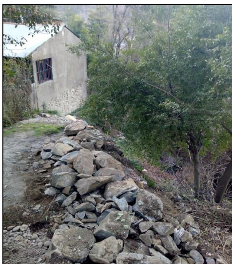
Imagen 28: Vivienda y material grueso a modo de relleno, al pie de ladera con pendiente pronunciada.
