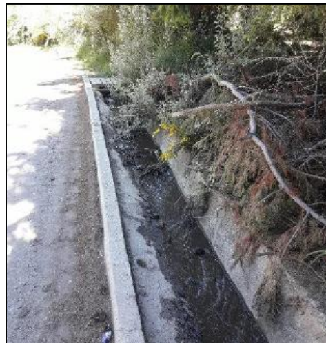
Imagen 3: Cuneta RP N°19
