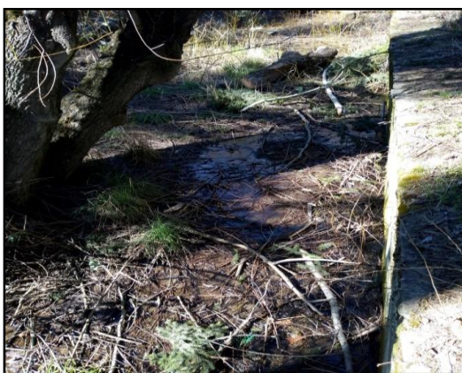
Imagen 13: Arroyo Cantera conducción rectangular enterrada de hormigón armado.
