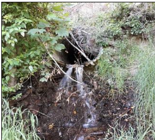
Imagen 9: Alcantarilla de ingreso al barrio
