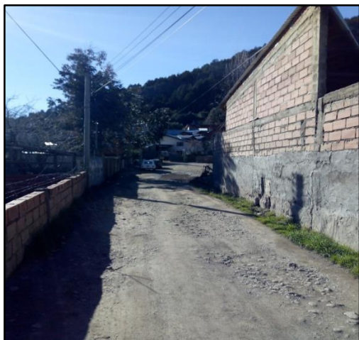
Imagen 42: Calle interna del barrio de una sola mano sin espacio para tránsito de peatones.
