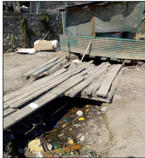
Imagen 64: Tramo del arroyo contaminado por residuos sólidos urbanos (RSU).
