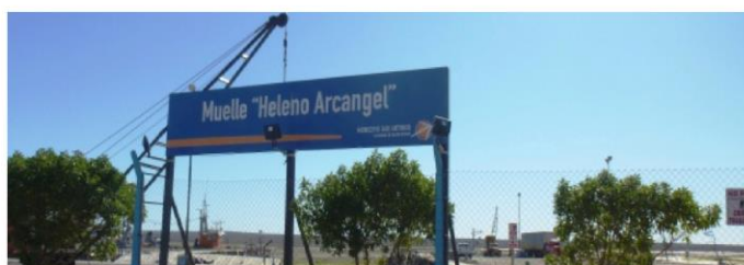
Foto Nº 10. Muelle Heleno Arcangel.
