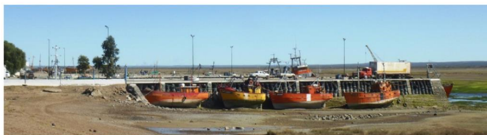
Foto Nº 11. Flota pesquera en el Muelle Heleno Arcangel, durante bajamar.
