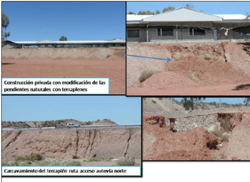
Figura 7.10: Obras con problemas al imponer nuevas pendientes no naturales.
