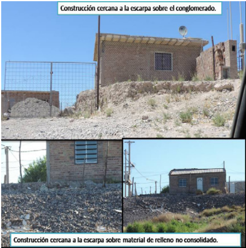
Figura 7.11: Vivienda en sectores de escarpa en el escalón de erosión.
