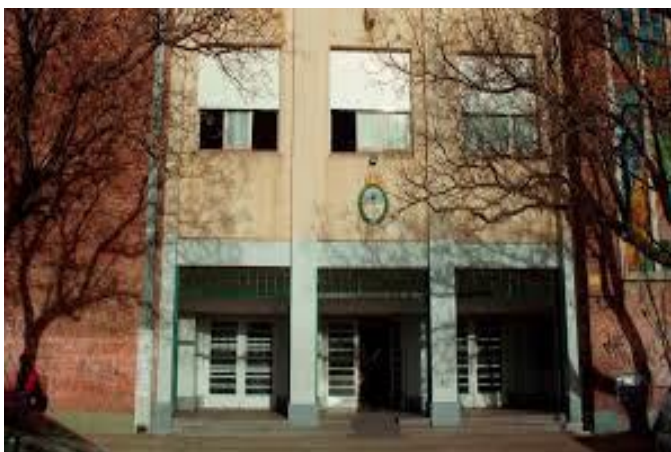
Figura 3. Edificio actual, situado en la calle 11 de abril 445.
