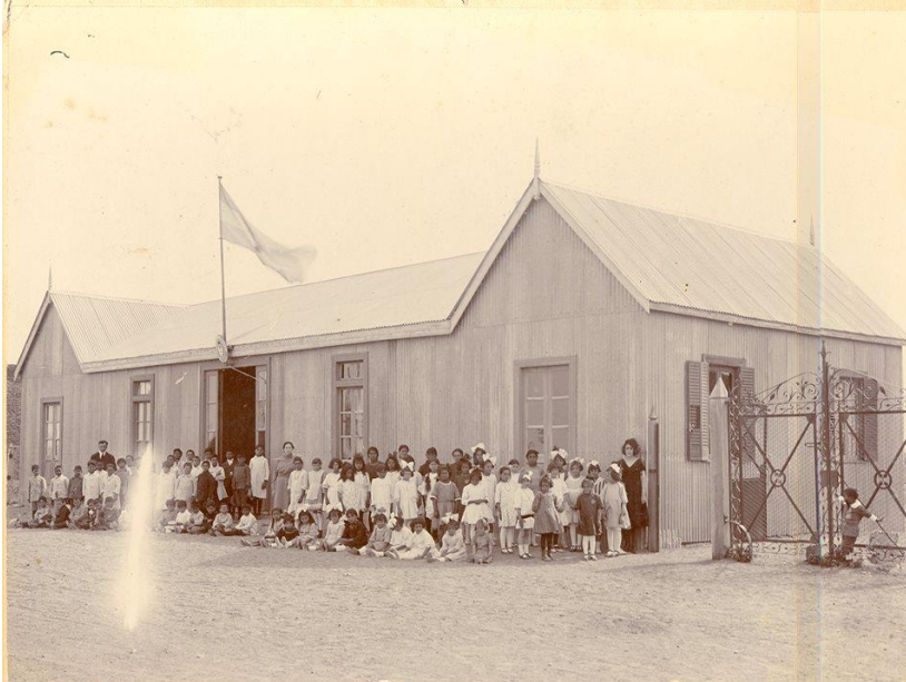
Escuela N° 6, San Antonio Oeste 1930
