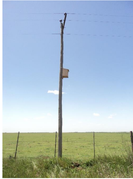
Figura 4. Caja nido de madera instalada en un poste de la línea eléctrica.
