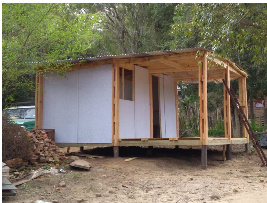
Imagen 3.5 - Vivienda de dos módulos habitables y dos módulos de galería. Fuente: Documentación provista por TECHO.
