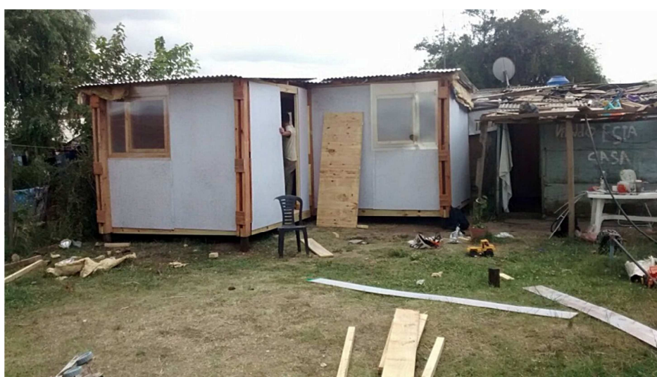
Imagen 3.6 - Vivienda de 3 módulos cerrados con disposición en ángulo. Fuente: Documentación provista por TECHO.
