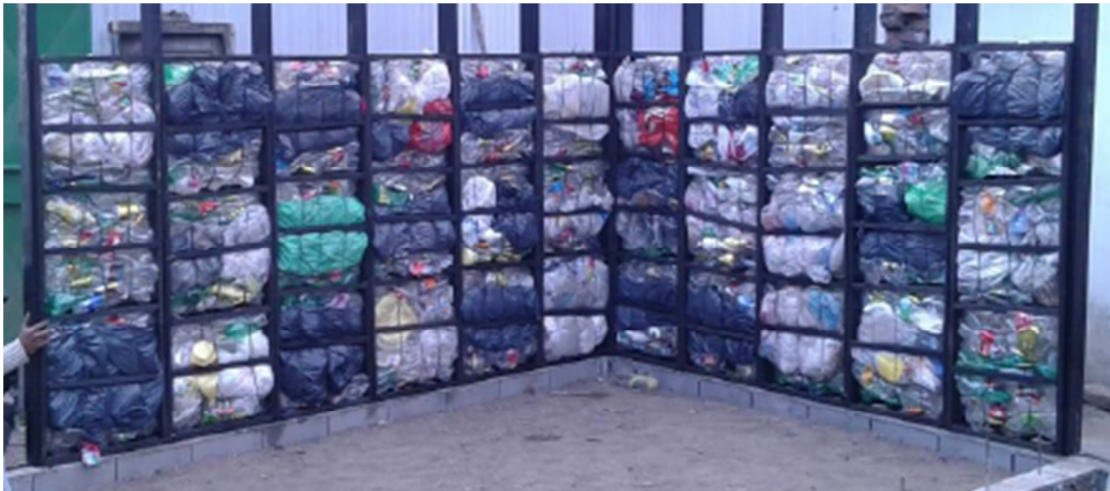
Imagen 5.2 - Sistema constructivo de Bloque 3c.
