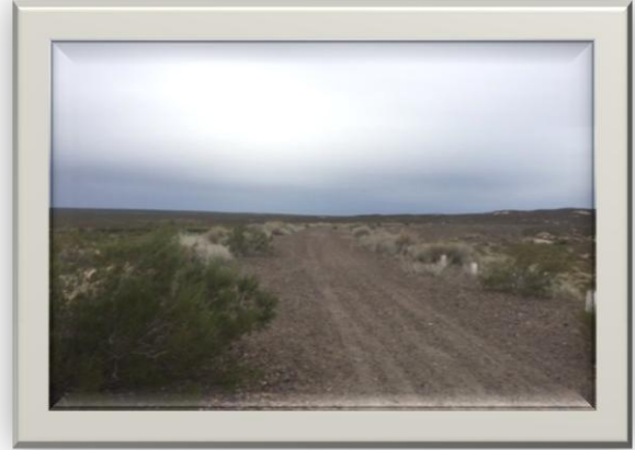
En la foto se observa la falta de mantenimiento en el coronamiento del Dique Roca
