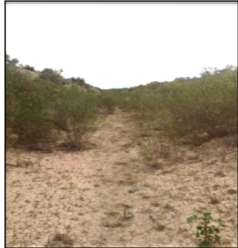
Figura 3.27.- Fotografía Canal de Trasvase 2018 b.
