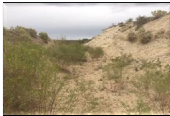
Figura 3.28.- Fotografía Canal de Trasvase 2018 c.
