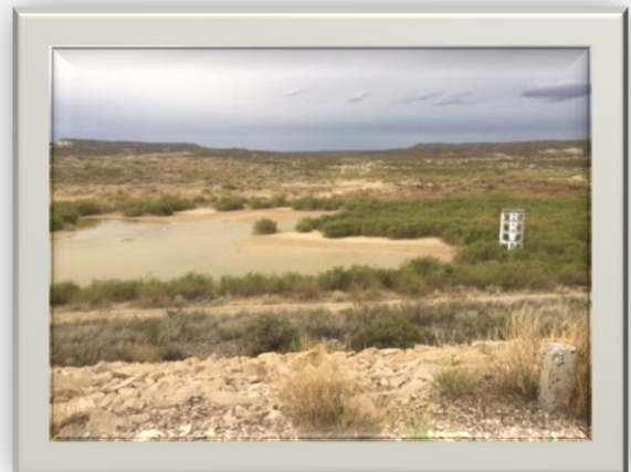
En la foto se observa la falta de Mantenimiento en la Cuenca Catini
