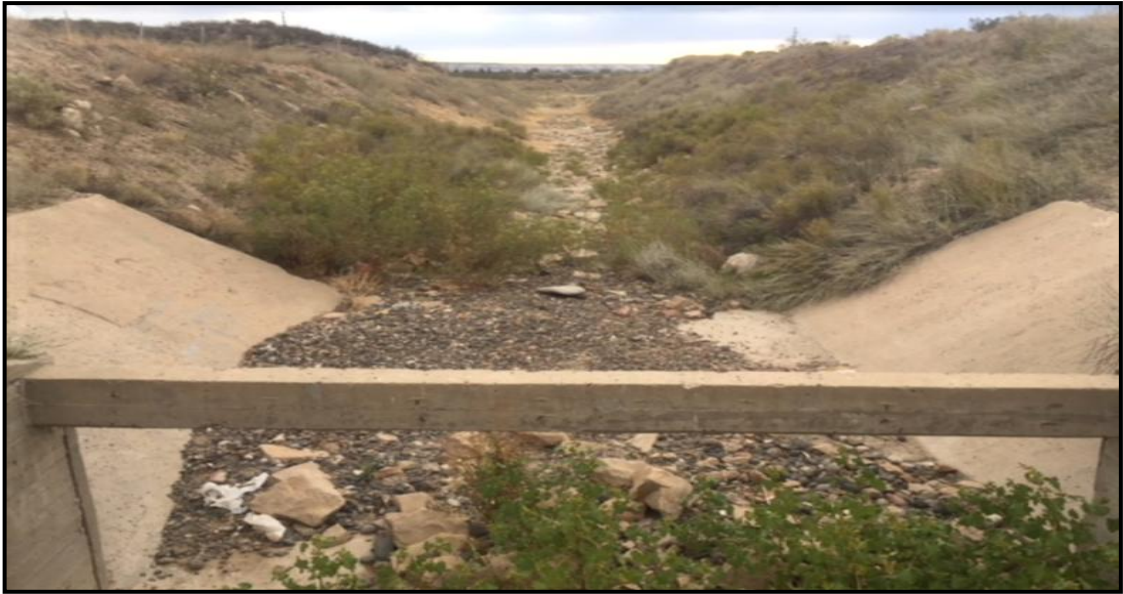
Figura 3.31.- Fotografía del Canal de Desagüe 2018.
