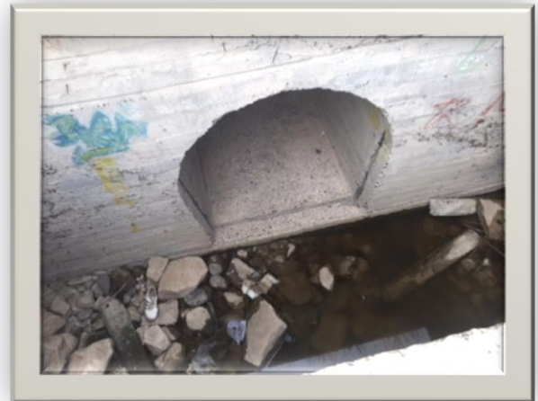
En la foto se observa la salida del descargador de fondo del Dique Catini-Libre de Obstrucciones.
