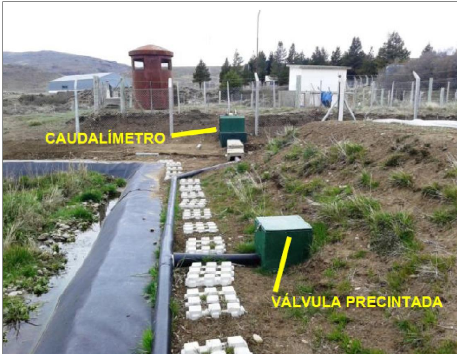
Figura N° 9: Conexión entre filtro vertical y filtro horizontal
