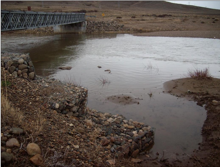
Figura N° 20: M 12 – Puente carretero RPL
