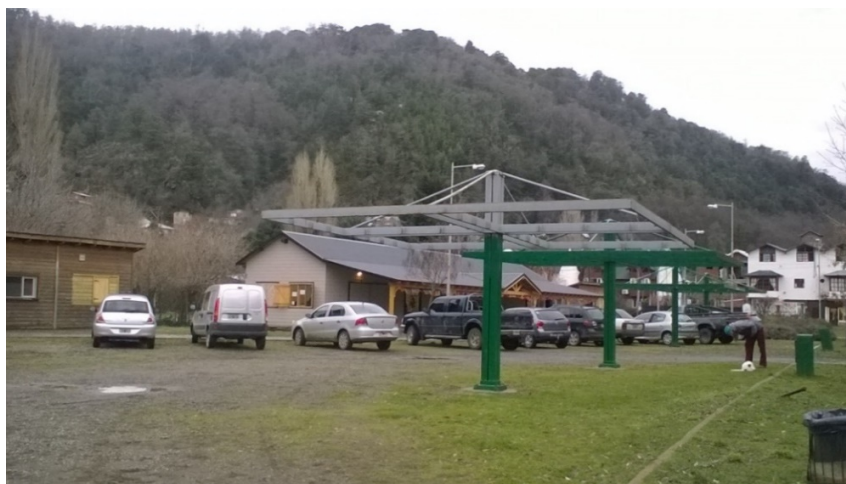
Fig.2. Vista general. Estacionamiento dentro de la Plaza. Suelo degradado.
