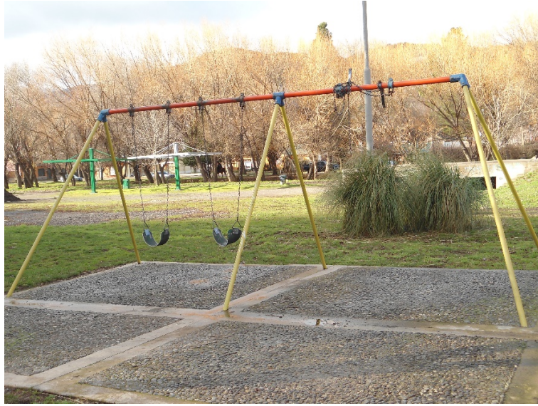
Fig.8. Base de hormigón y piedras para la instalación de hamacas que NO debería utilizarse.
